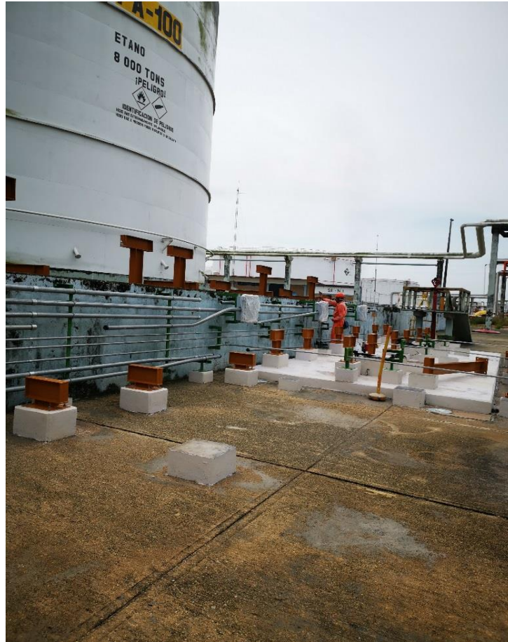
Cimentación de las nuevas bombas
