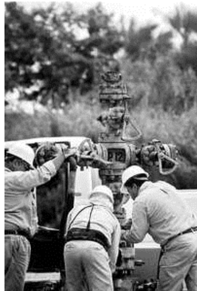
Trabajadores de Pemex dan mantenimiento a las válvulas de una batería en el campo petrolero San Ramón, en Cárdenas, Tabasco. Foto Notimex
