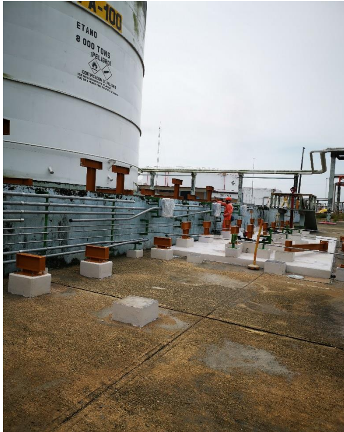
Cimentación de las nuevas bombas
