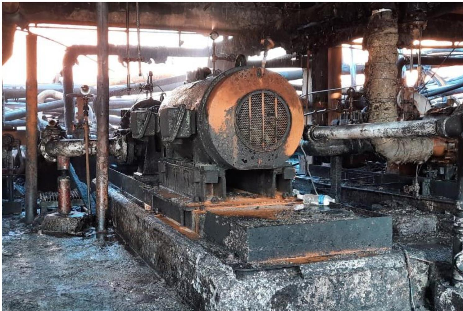
Esta fotografía muestra los daños sufridos en la bomba de repuesto de carga de gasolina amarga, al lado se encuentra la bomba accionada por turbina.
