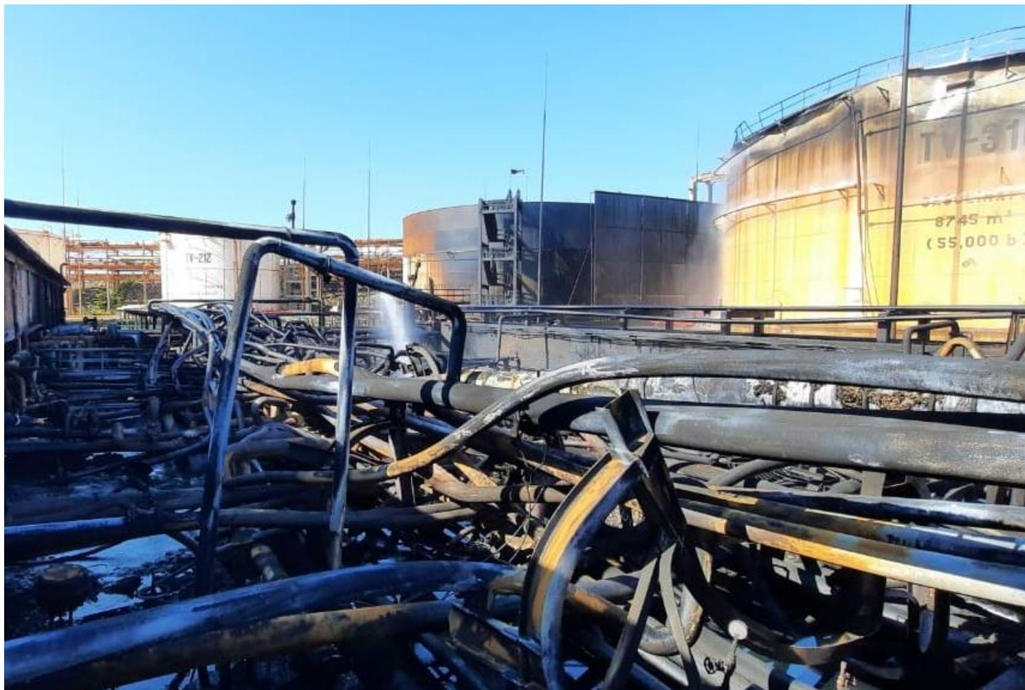
Daños causados por el incendio en la sección de almacenamiento de gasolina amarga y en las tuberías
