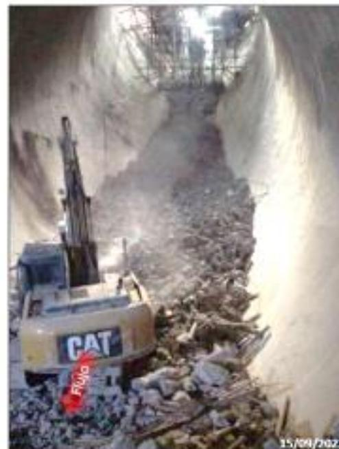
Limpieza de resaga producto de demolición en el
