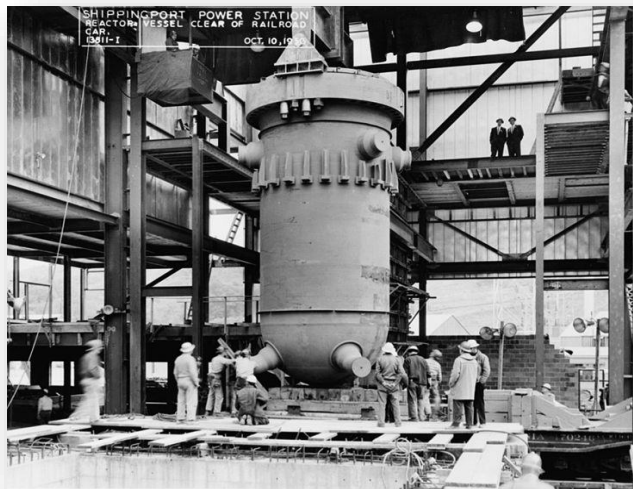
Shippingport Reactor PWR: Proyecto demostrativo. Instalación de la vasija. Inicio Operación 1957
